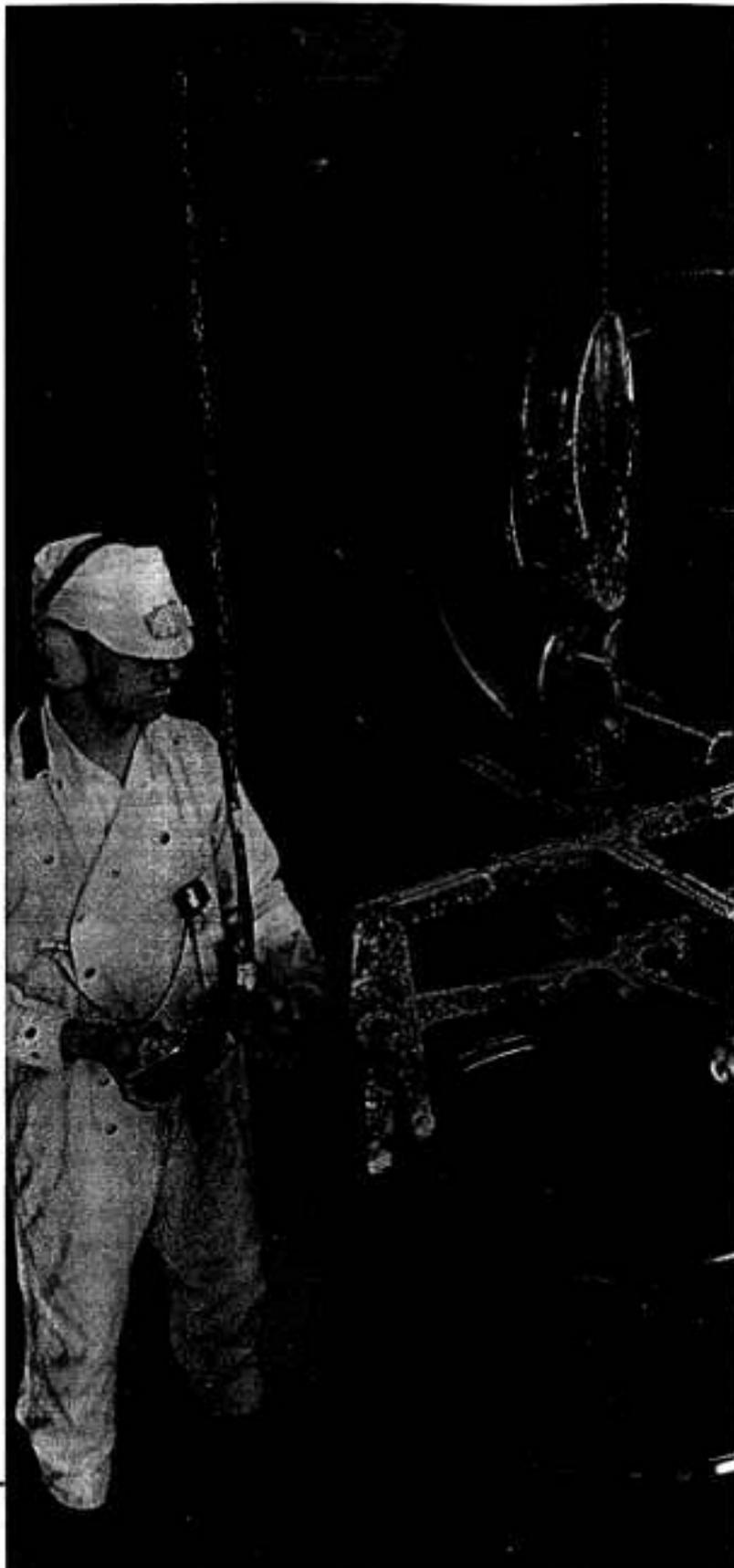
Conditionnement de déchets radioactifs dans du béton en vue du rejet en mer.
